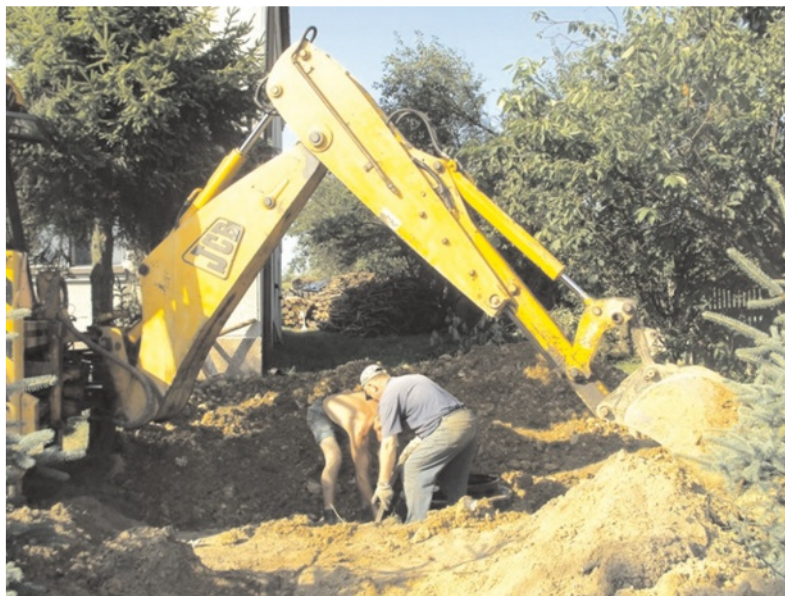
Prace nad budową kanalizacji w Zadrożu
